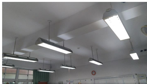
換裝 LED2 燈管
